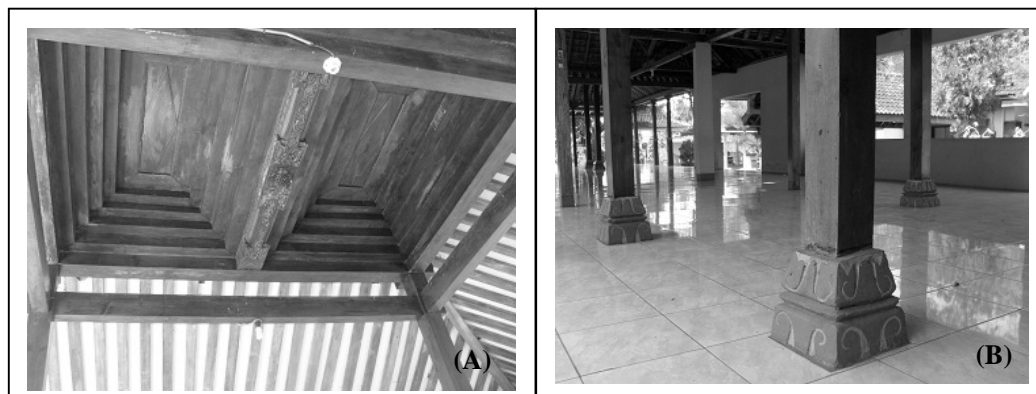
Gambar 2. Konstruksi bangunan rumah joglo di Tamanan, Banguntapan, Bantul. Konstruksi atap limasan dan tiang saka dengan menggunakan bahan kayu (gambar A) dimana tiang saka dipikulkan pada pondasi umpak. Batuan beku andesit dipergunakan sebagai umpak pada bangunan rumah joglo tersebut (gambar B). Gambar foto koleksi penulis.
